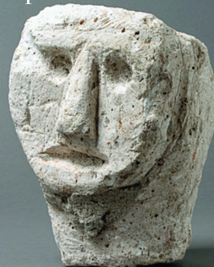
Modillon , élément d'architecture qui soutient un balcon ou une corniche, découvert dans une maison du XIII e siècle (13 e siècle). © Inrap - Laurent Petit
